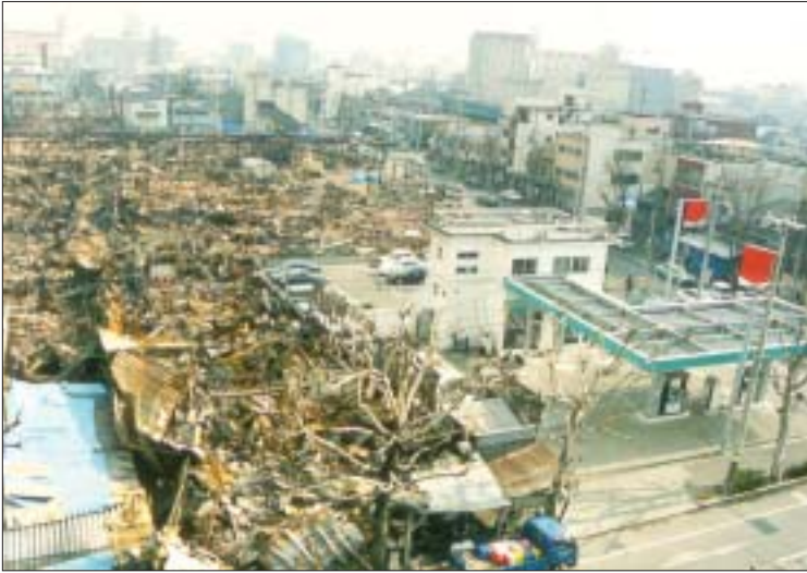
阪神・淡路大震災で倒壊も焼けもせずに残ったガソリンスタンド 写真提供:兵庫県石油商業組合
